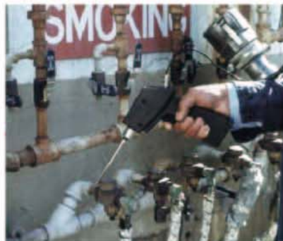
Inspección de trampas de vapor
