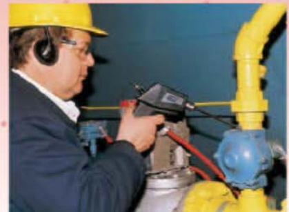
Ultraprobe 100 inspeccionando fugas en las válvulas del sistema de bombeo.
