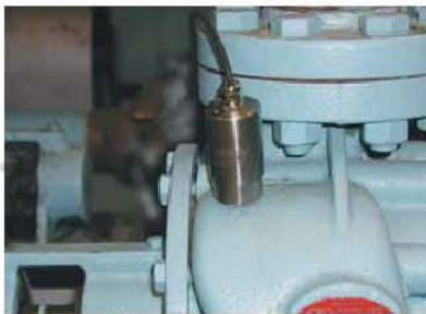
Monitorea cavitación, rodamientos y válvulas.
